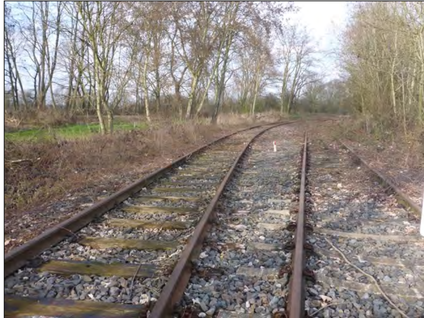
Abb. 2: Bahnlinie im Norden, östlicher Abschnitt hinter der Weiche
