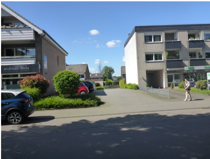
Bebauung nördlich der Dorstener Straße im Abschnitt östlich des Rochecorboner Platzes
