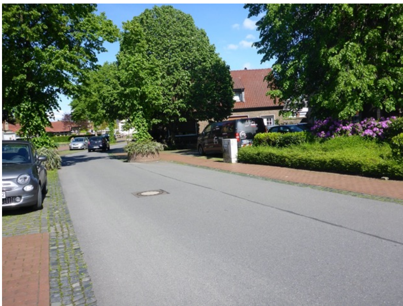
Dorstener Straße im Bereich der evangelischen Dorfkirche (Blick in östliche Richtung)
