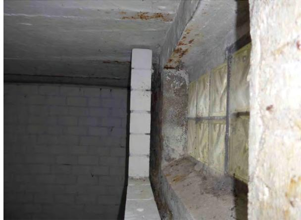
Foto 56: ... läßt in einem Kellerraum einen breiten Spalt entstehen
