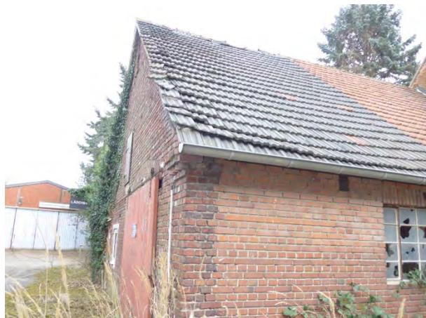
Foto 18: ... hinterer Anbau mit massiven Schäden im Dach- und den Fenstern
