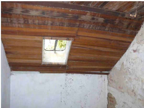
Foto 29: Dachschrägen im Haupthaus teilverkleidet (massive Schäden)
