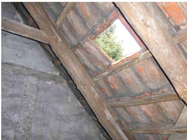
Foto 35: Defekte bzw. fehlende Dachpfannen ermöglichen einen Einflug ...
